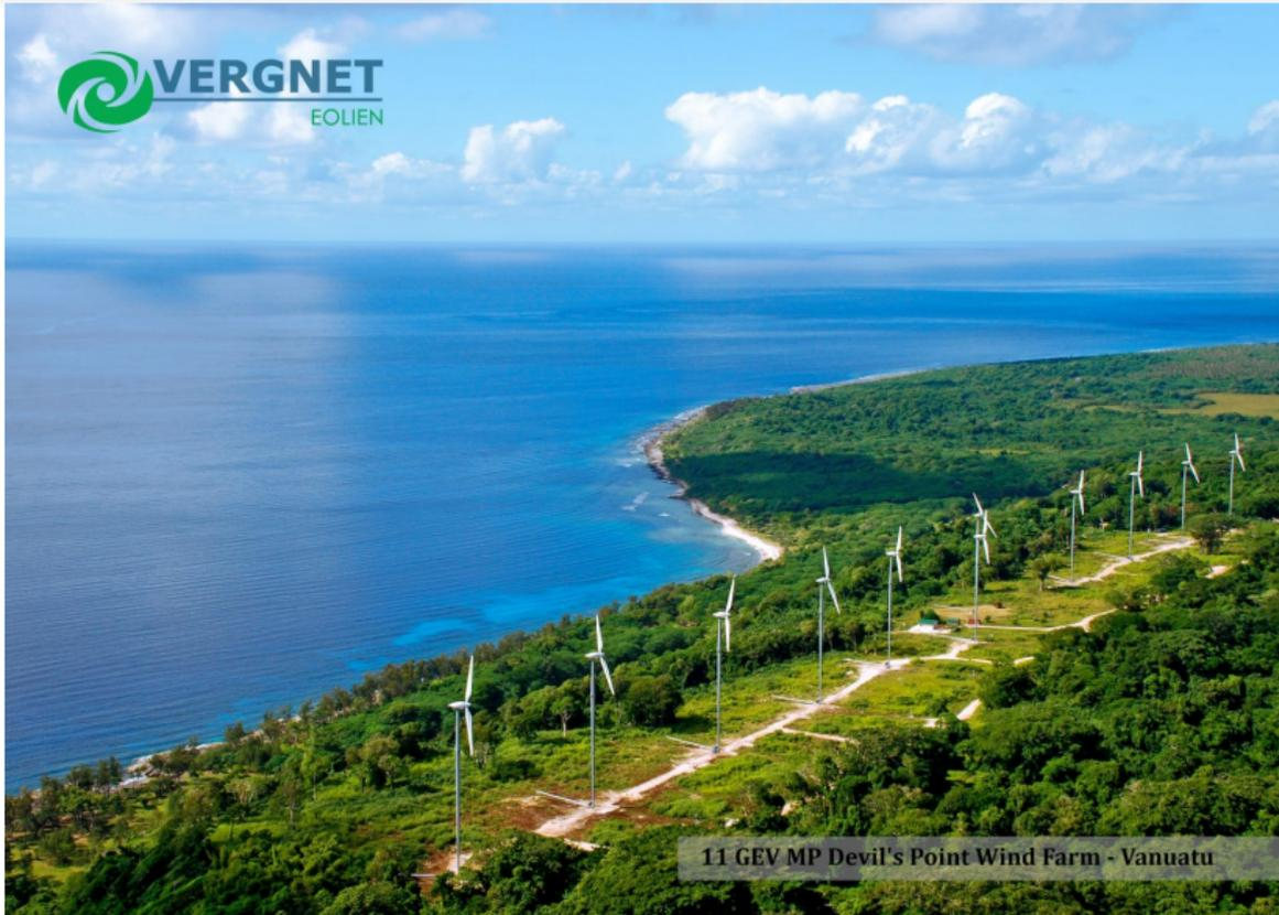
Exemple de turbines anticycloniques de ~250 kW au Vanuatu
